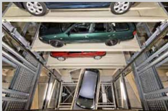
**sporge sulla strada, è stata conservata, mentre il retro dell'immobile è stato completamente demolito per dare spazio alla struttura dell'autorimessa. La parte frontale dello stabile ospita l'entrata, l'uscita e l'area di servizio per il posteggio delle auto, mentre dietro alla facciata ristrutturata vi sono 13 livelli di parcheggio. La soluzione finale è stata quella di applicare 3+1 piattaforme a lato dell'elevatore verticale.**
