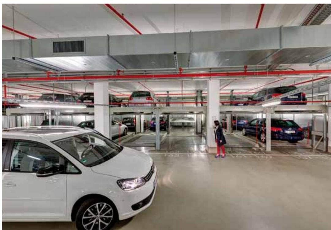
Se si fosse utilizzato un altro sistema di parcheggio per ottenere 76 posti auto sarebbe stato necessario occupare una superficie di circa 1567 m<sup>2</sup> mentre con il nuovo Combilift 552, sono stati utilizzati solo 964 m<sup>2</sup>. L'utente avvia il processo di parcheggio selezionando il proprio posto auto (sito nella fila più lontana sul livello superiore) dal pannello di comando. Le piattaforme che precedono quella del posto auto selezionato
