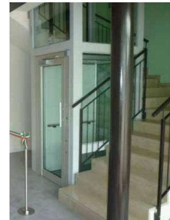
La presenza di un vano scala libero in tutta la sua altezza ha reso possibile il posizionamento di un elevatore. La scelta dell'impianto da installare è ricaduta su una piattaforma elevatrice oleodinamica con fossa e testata ridotte della ditta Stevan Elevatori. L'impianto è stato realizzato con struttura panoramica, cabina con pareti in vetro molto estese e porte
