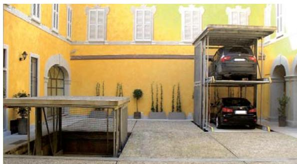
**E**cco l'esempio pratico di come sono stati realizzati 18 posti auto nel parcheggio di Crema. Viene realizzato uno scavo di 9x16,5 m, con una profondità di 5 m. Complessivamente trovano spazio 9 impianti Idealpark modello IP2-C per un totale di 18 posti auto.
