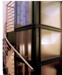
spazi disponibili nei quali inserire i montanti per costruire l'ossatura della struttura. Ci siamo così resi conto che andando a posizionare quattro angolari ad L agli angoli si poteva creare il rivestimento della struttura esternamente al vano.
